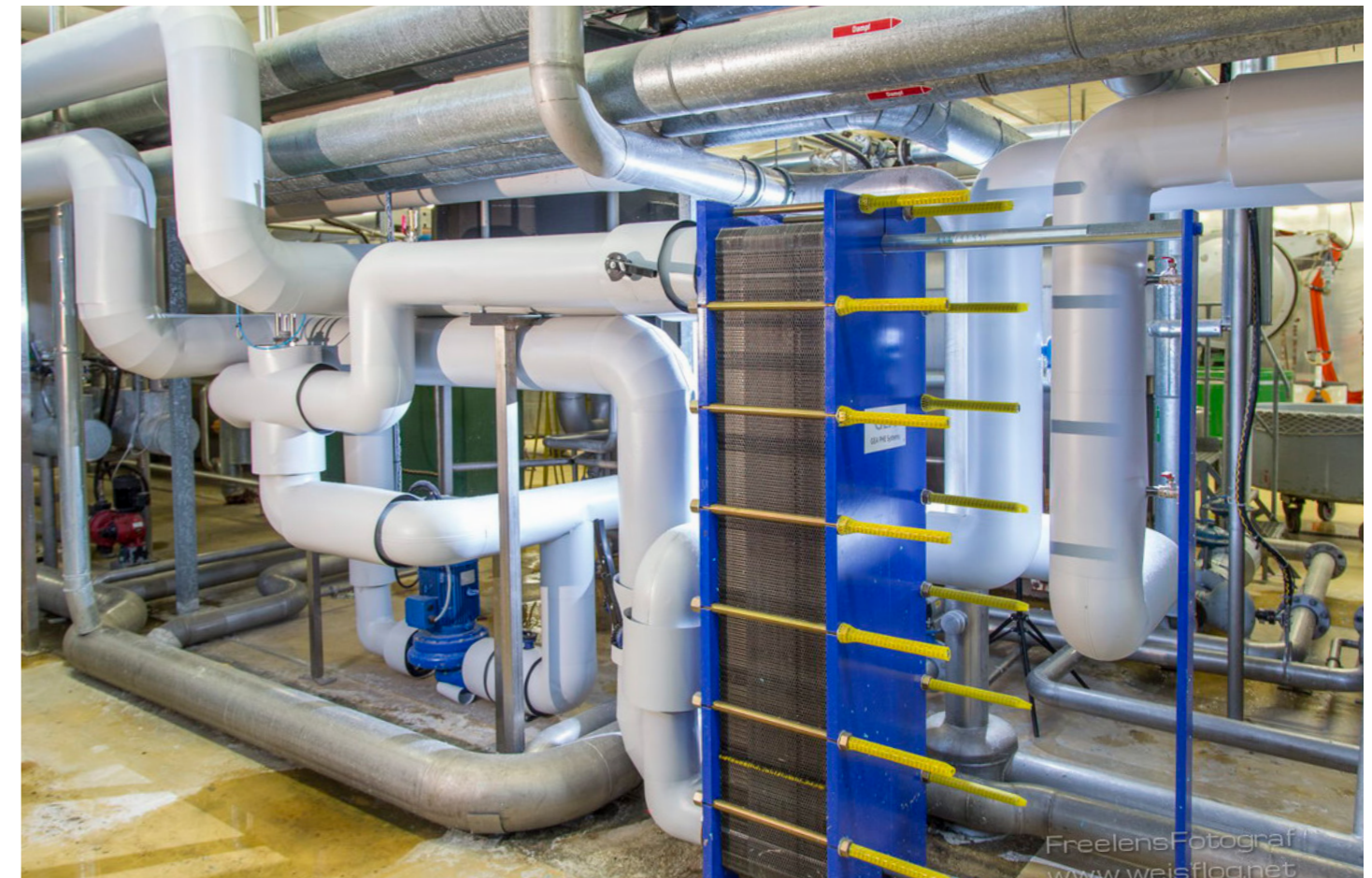
Nutzung der Abwärme aus einem Blockheizkraftwerk mittels Plattenwärmeübertrager (S. 15) bei Frottana Textil GmbH & Co. KG in Großschönau (Lausitz)
