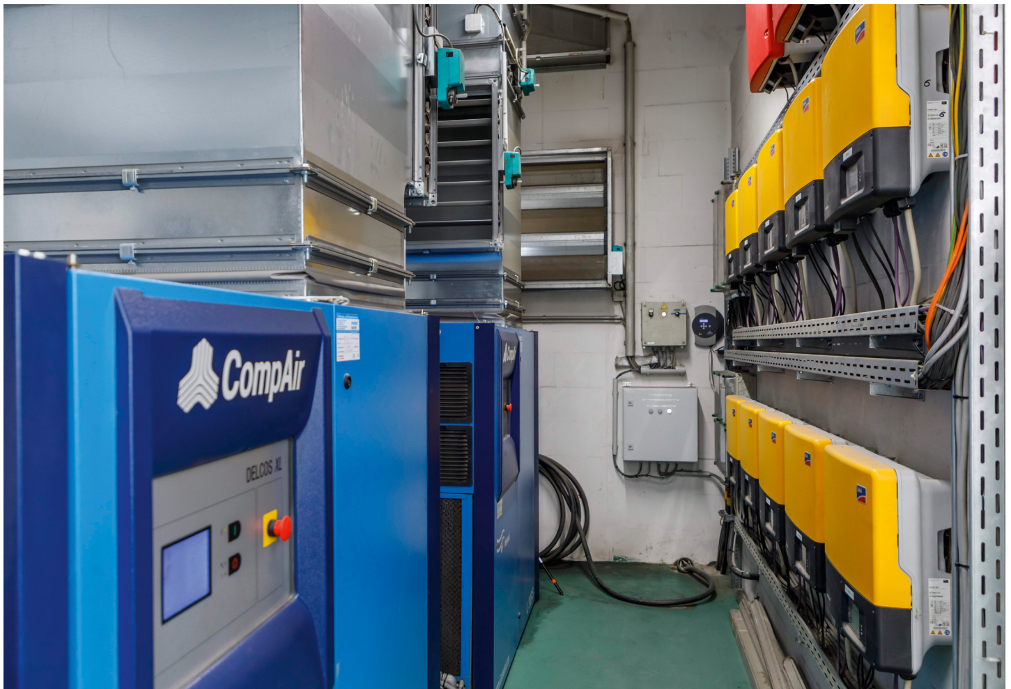
Abwärmennutzung aus Druckluft
