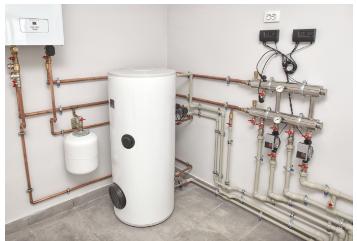
Pufferspeicher für Warmwasserbereitung
