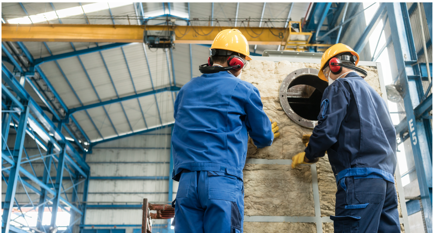
Anbringen einer Isolationsschicht an einen Kessel
